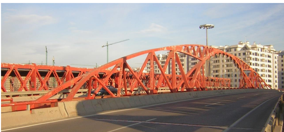
Vistas del puente Rojo
