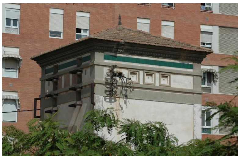
Imagen del Centro de Transformación
