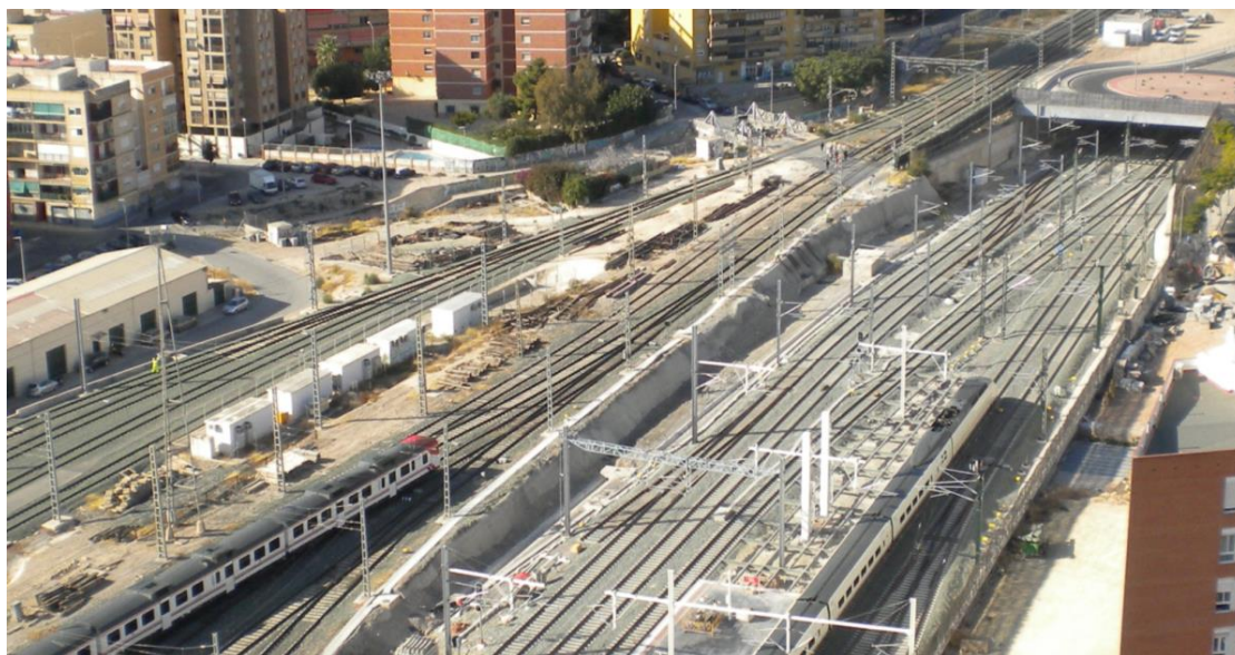
Vista parcial de las obras de soterramiento. Final del cajón actual, y sobre el mismo, rotonda Gutiérrez Mellado.
