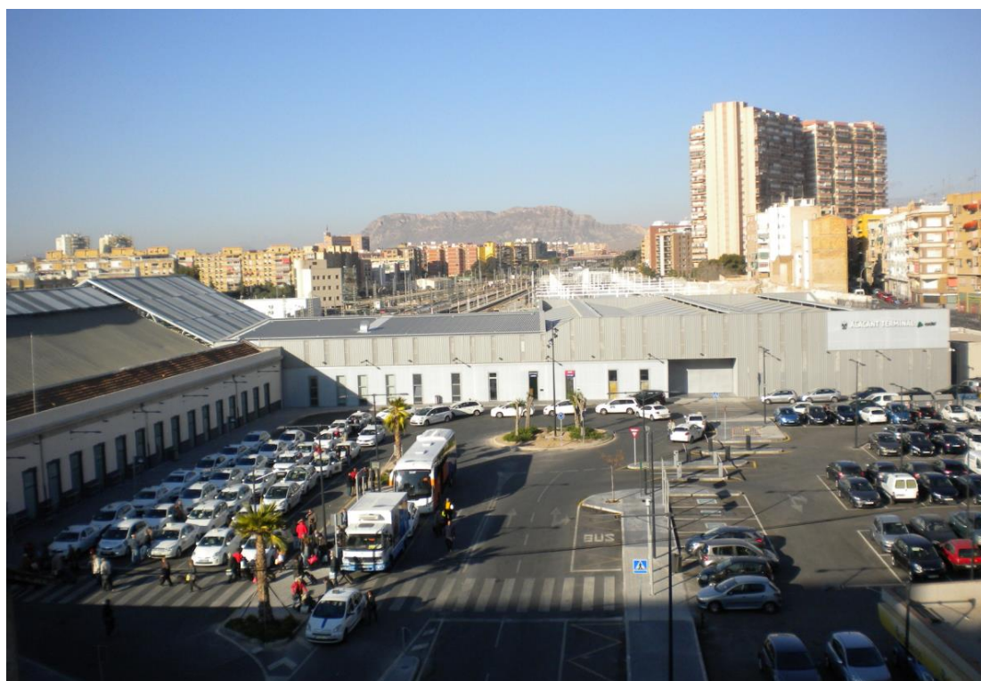
Vista de la estación provisional.
